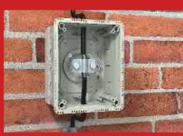
spoj traka za uzemljenje
